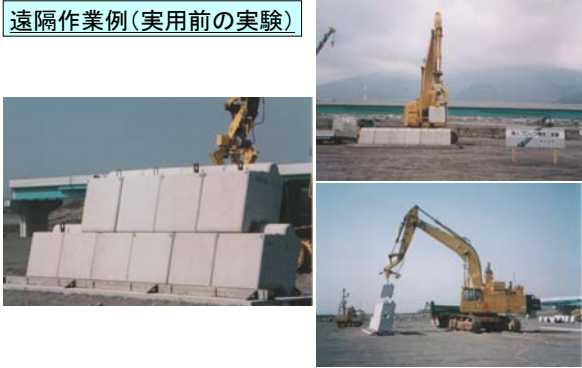
(雲仙山麓・警戒区域でのダム建設に用いられた工法)
