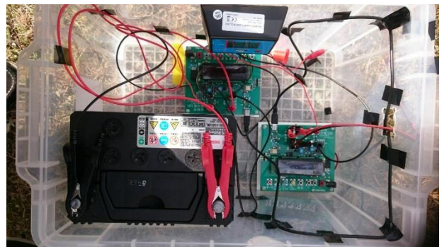
図 13 充電量, 発電量を計測し蓄電する装置
